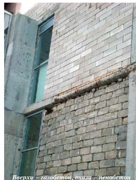
Вверху – газобетон, внизу – пенобетон
