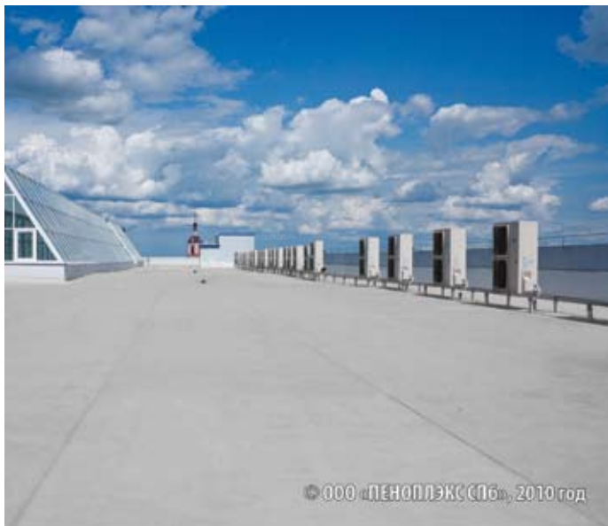
Фото 1. Кровля гостиничного комплекса, Рязань
