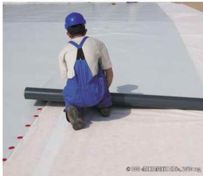
Фото 2. Кровля складского терминала, Санкт-Петербург
