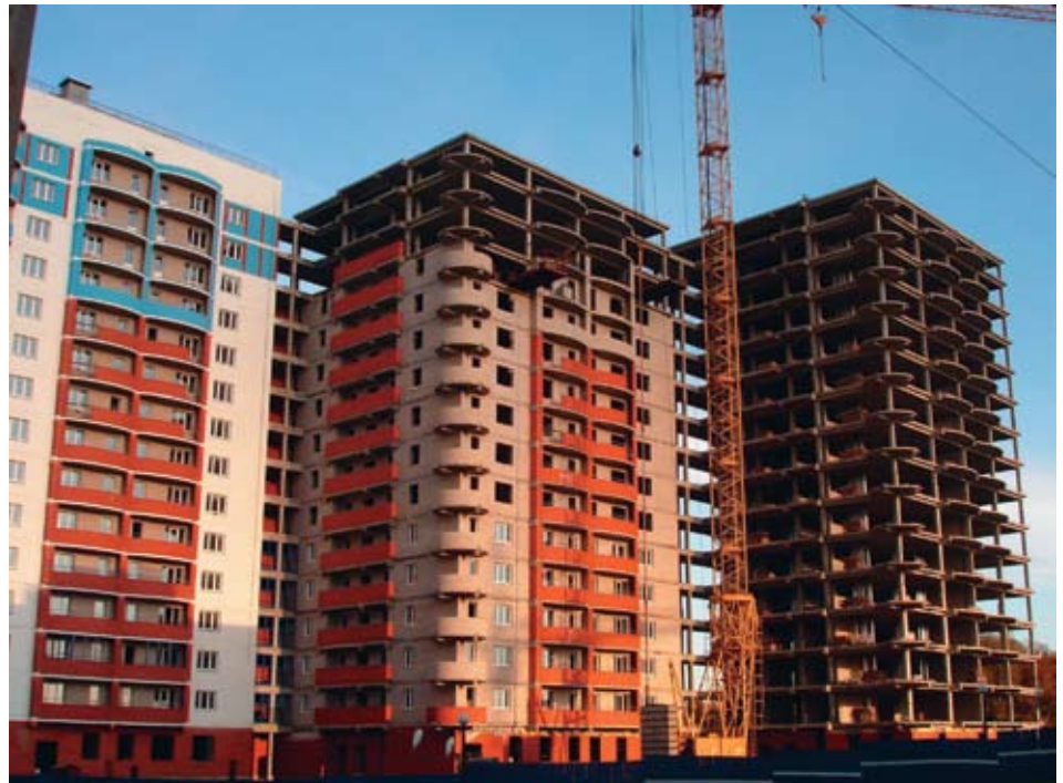
Жилые 9-17-этажные дома нового микрорайона, построенные с применением сборно-монолитного каркаса с пустотным настилом, г. Киров, 2009 г.
