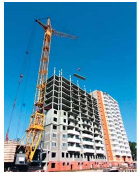
Строительство 15-этажного жилого дома с применением сборно-монолитного каркаса с пустотным настилом и 3-слойной «НС» нового типа, г. Чебоксары, 2010 г.
