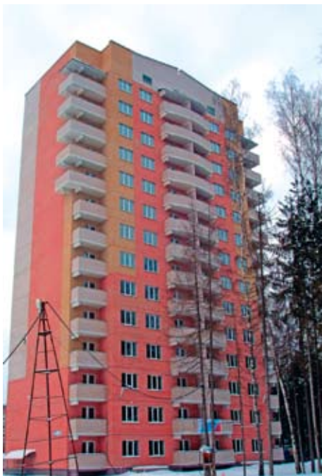
Монтаж и строительство жилого микрорайона с применением сборно-монолитного каркаса. Конструкции СМК изготовлены на заводе «НСС» группы компаний «ПиК», г. Обнинск, Калужская область, 2011 г.
