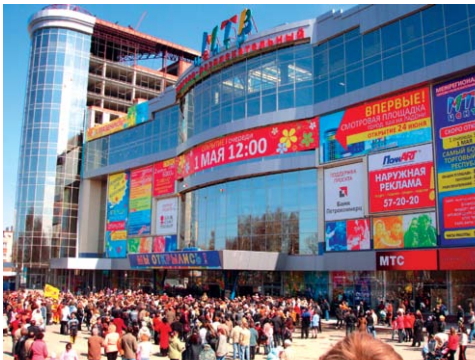
Пуск в эксплуатацию 1-й очереди (40 тыс. кв. м из 120 тыс. кв. м общей площади) торгово-развлекательного комплекса. Применен сборно-монолитный каркас с шагом колонн до 15 м и высотой этажа до 7,2 м. Монтаж каркаса - ООО «Каркас-Ч», г. Чебоксары, 2009 г.
