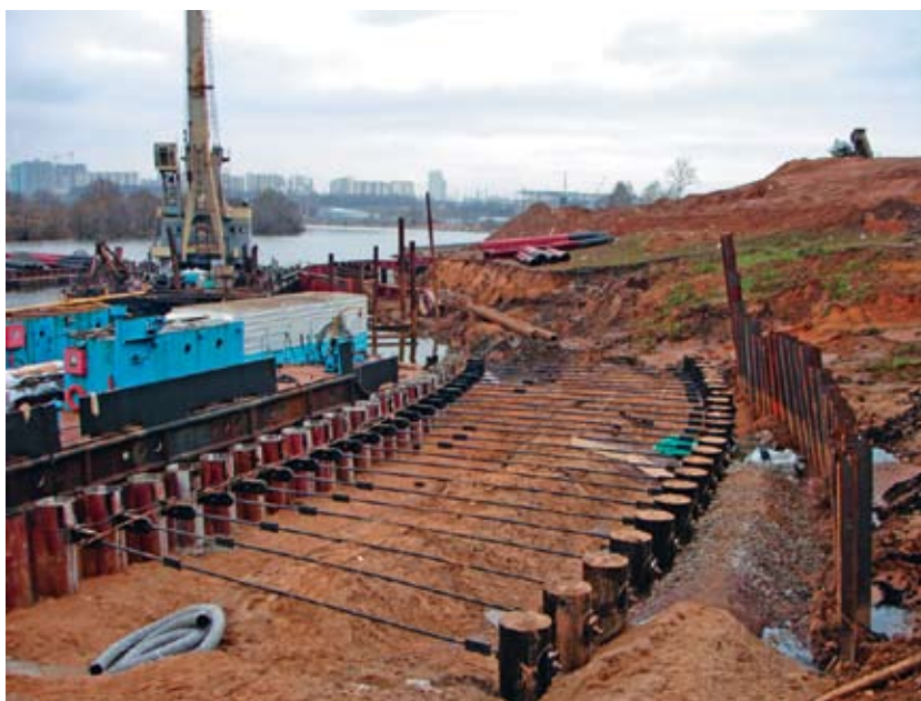
Фото 2. Подпорная стенка из шпунта трубчатого сварного с анкеровкой
