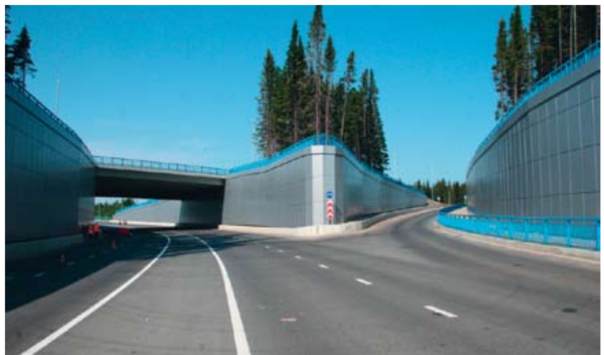
Фото 3. Объездная дорога г. Ханты-Мансийска с подпорными стенами с использованием ШТС
