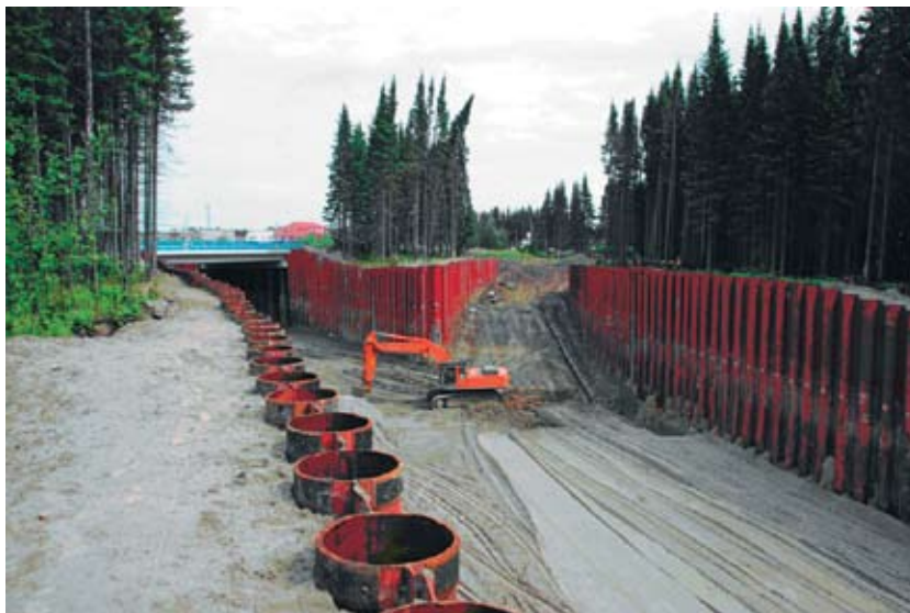
Фото 1. Подпорная стенка из шпунта трубчатого сварного
