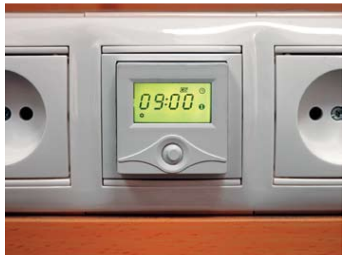
Программируемый термостат NLC-527H, смонтированный в установочную коробку
