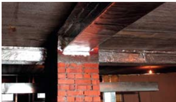
Конструктивная огнезащита ET ПРОФИЛЬ производства ОАО «ТИЗОЛ» после 5 лет эксплуатации на металлоконструкции
