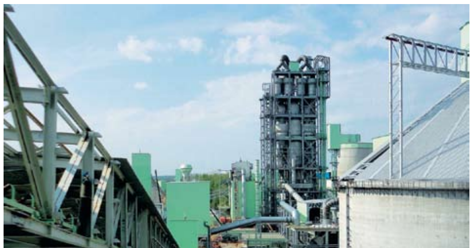
Цементный завод ООО «Тулацемент» (ХайдельбергЦемент), пос. Новогуровский
