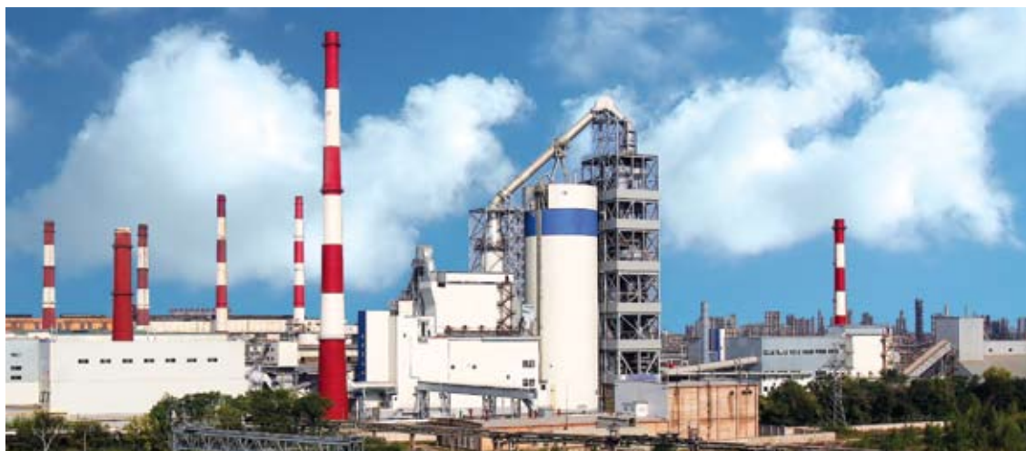
Завод ЗАО «Строительные материалы» (ХайдельбергЦемент), г. Стерлитамак
