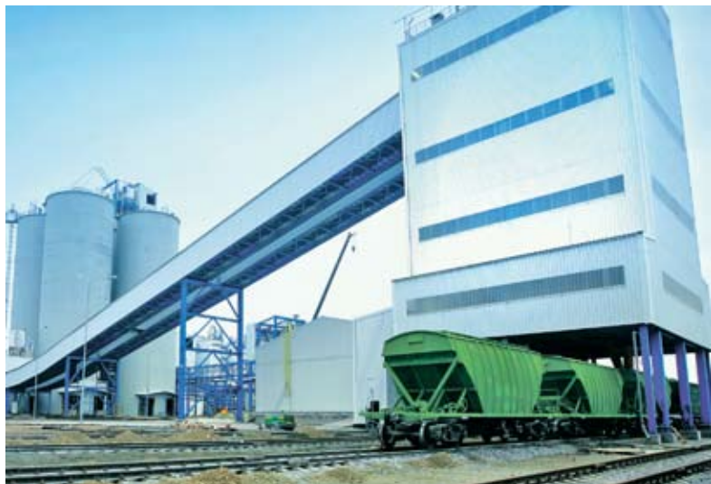
Завод «ЛСР-ЦЕМЕНТ». Отгрузка в вагоны на двух путях в автоматическом режиме
