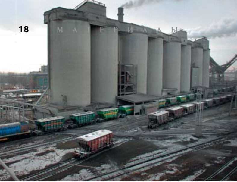
Большой объем силосов Топкинского цементного завода (ОАО «ХК «Сибцем») позволяет формировать значительный запас цемента для организации бесперебойных поставок в летние месяцы
