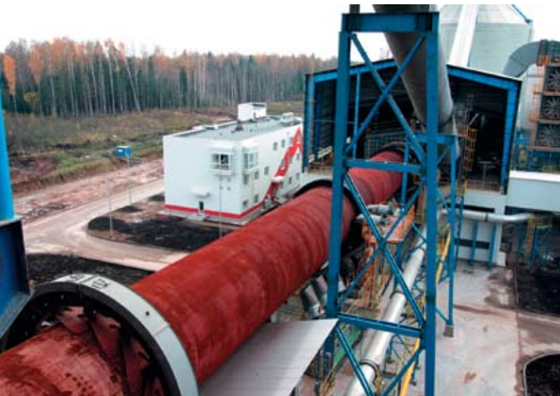
Завод «ЛСР-ЦЕМЕНТ». Вращающаяся печь производительностью 5 тыс. т клинкера в сутки
