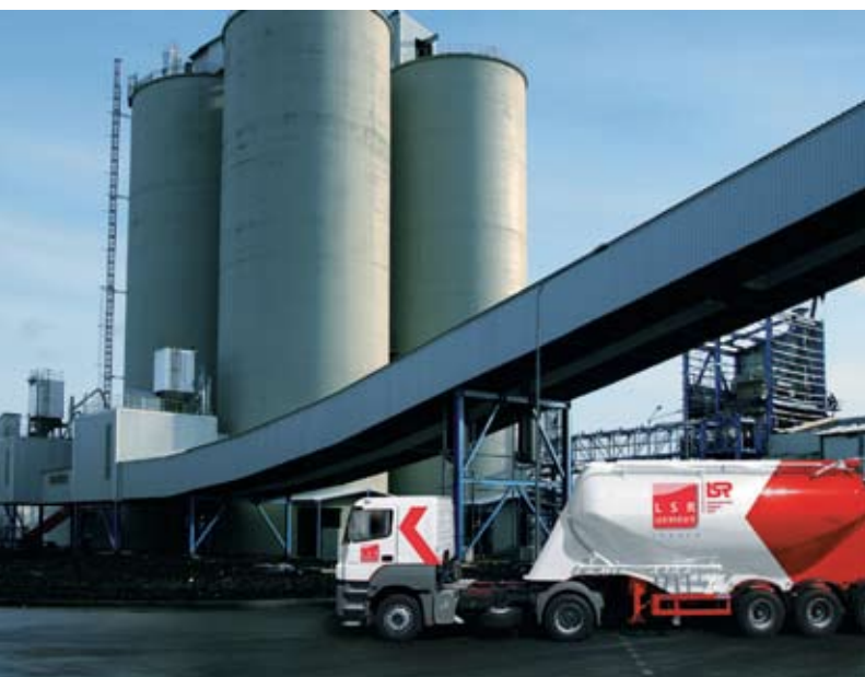
Завод «ЛСР-ЦЕМЕНТ». Автоматизированная отгрузка цемента из 4-х силосов в автотранспорт
