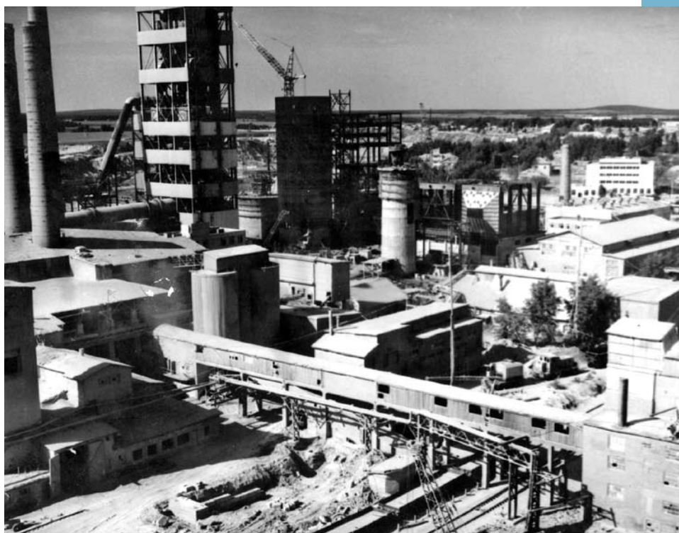
Панорама строительства Невьянского цементного завода. 1987 год
