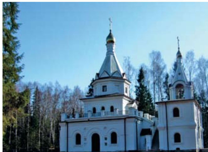
Рис. 3. Церковь «Всех Святых», Дубна, Московская область. Купола церкви — из наноцемента, толщина стенок куполов — 40 мм
