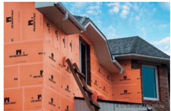
Пример применения теплоизоляции ПЕНОПЛЭКС® на фасаде малоэтажного дома
