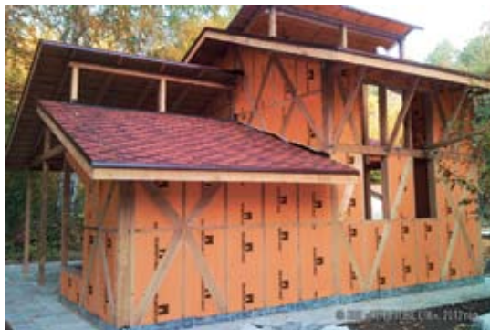
Пример применения теплоизоляции ПЕНОПЛЭКС® на фасаде малоэтажного дома
