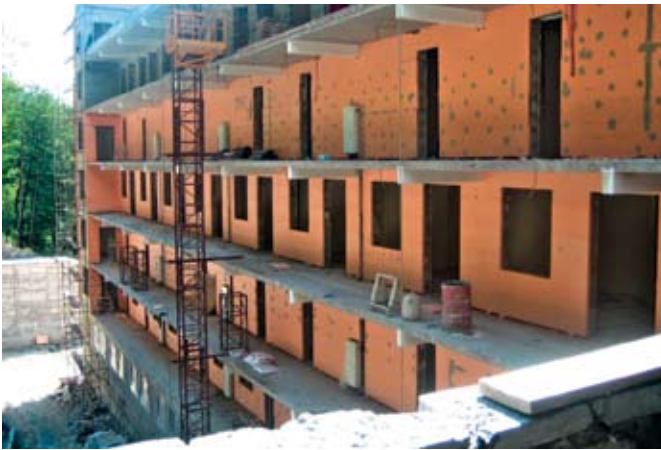
Пример применения теплоизоляции ПЕНОПЛЭКС® на фасаде многоквартирного дома
