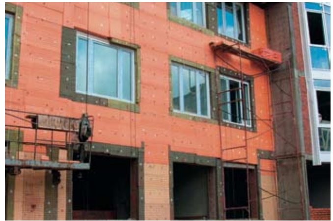
Пример применения теплоизоляции ПЕНОПЛЭКС® на фасаде многоквартирного дома
