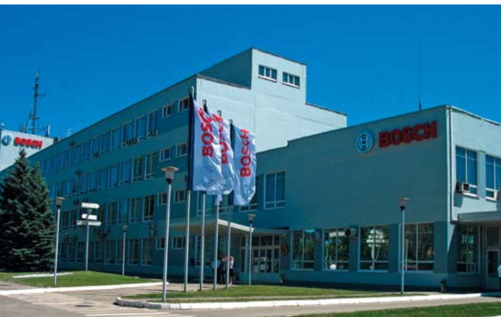
Завод Бош Отопительные Системы, г.Энгельс
