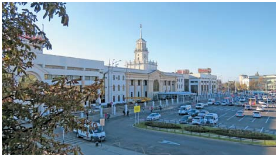
Фото 2. Краснодар, Привокзальная площадь. Реставрация и реконструкция железнодорожного вокзала
