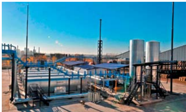
Рис. 1. Секция ПБВ фирмы MASSENZA на Омском НПЗ
