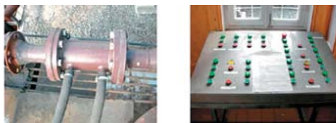
Рис. 3. Кавитационная установка и пульт управления на АБЗ в г. Гомель
