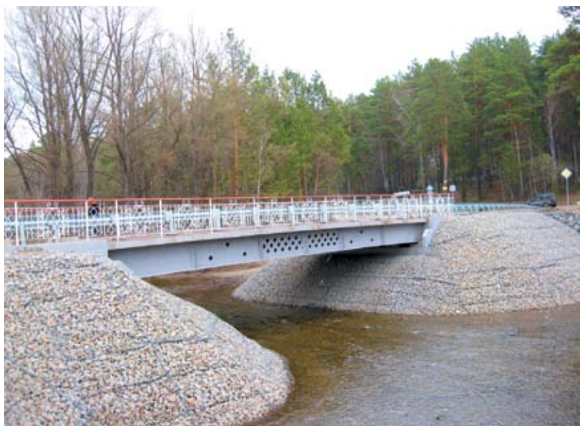
Рис. 1. Вид первого композитного моста к концу второго года эксплуатации
