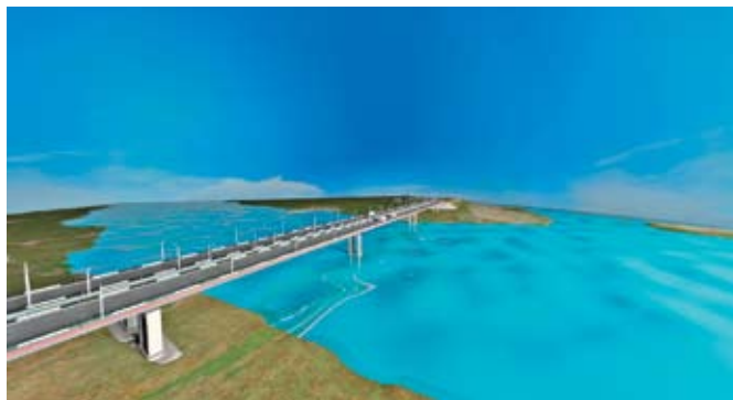
Рис. 1. Визуализация процесса строительства искусственных сооружений на примере Аксайского моста через реку Дон в Ростове-на-Дону
