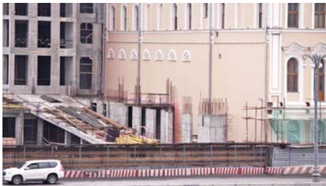
Фото 3. Гостиничный комплекс «Царев сад» на Софийской набережной, г. Москва. Применение системы деформационных швов между строящимся и существующим зданием
