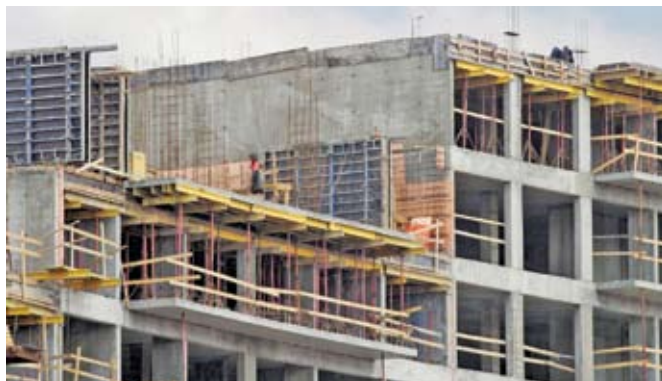
Фото 2. ЖК «Три ветра», г. Санкт-Петербург. Пример применения ПЕНОПЛЭКС® в системе деформационных швов
