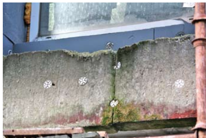
Рис. 1. Внешний вид пораженной грибом минеральной ваты на фасаде: биообращание, вызванное сообществом микроорганизмов — грибов, водорослей, мхов
