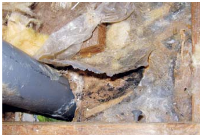
Рис. 3. Рост колоний плесневых грибов в минераловатном утеплителе
