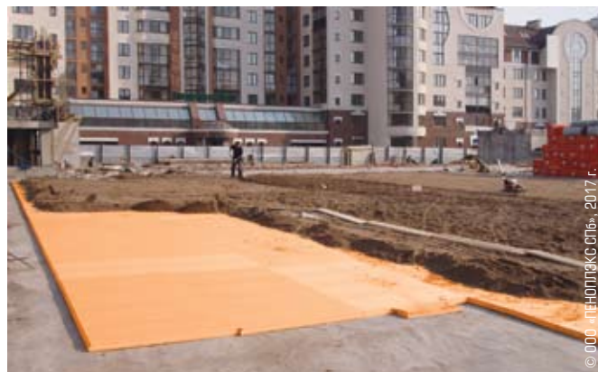
Рис. 1. Устройство эксплуатируемого покрытия: 1 – балластный слой, 2 – песчаная подушка, 3 – дренажный слой, 4 – ПЕНОПЛЭКС®, 5 – геотекстиль, 6 – PLASTFOIL®Geo, 7 – геотекстиль 300 гр/м 2 , 8 – железобетонное основание
