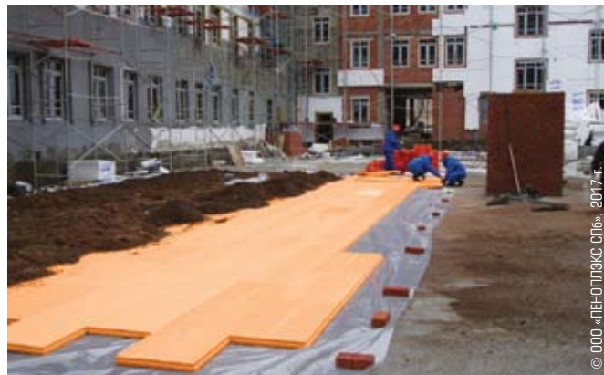
Рис. 2, 3. Примеры использования теплоизоляции ПЕНОПЛЭКС® при строительстве эксплуатируемых покрытий
