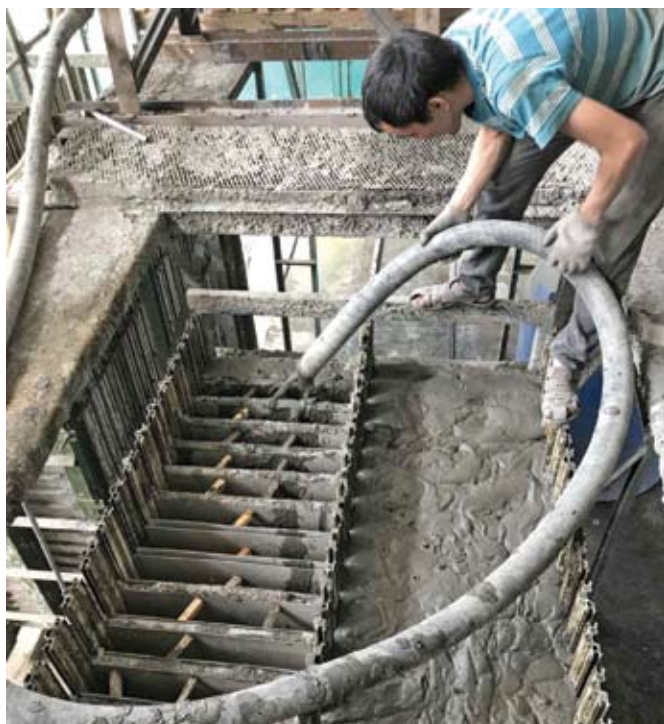
Рисунок 5. Заливка кассетной установки пенобетонной смесью
