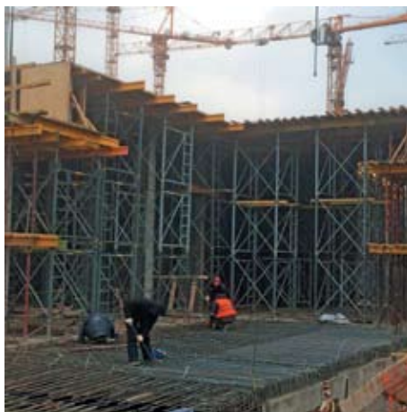
Рис. 8. Строительство ЖК «ЗИЛАРТ», г. Москва
