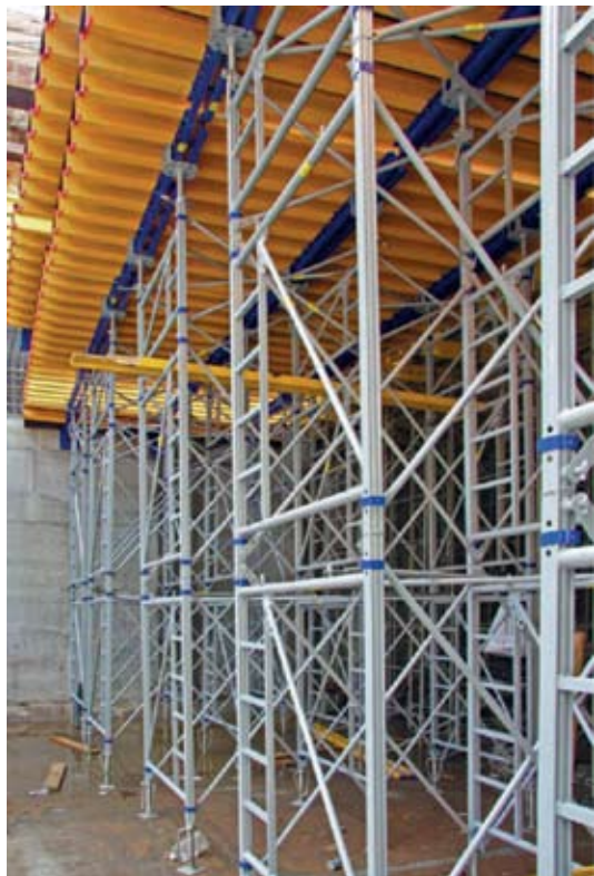
Рис. 7. Строительство метрополитена, г. Баку
