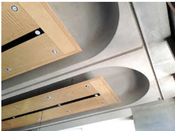
Рис. 11. Плита перекрытия из геополимерного бетона, г. Квинсленд, Австралия (Wagners)
